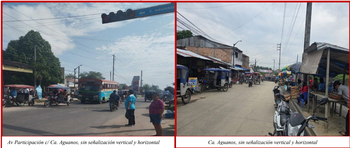
Figura N°32: Falta de Señalización
