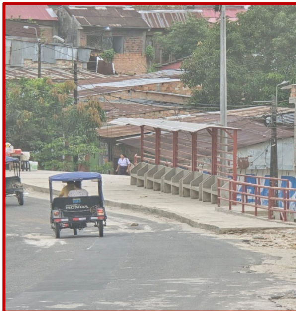
Fotografía N°01: Se puede evidenciar paradero en la calle Isabela Católica
